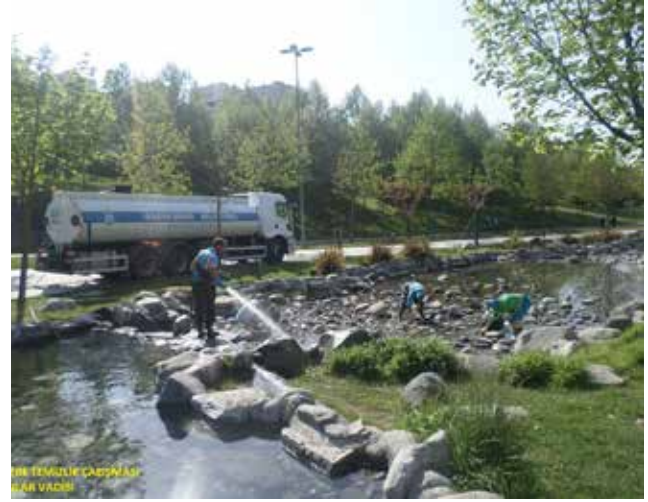
➤ DERE TEMİZLİĞİ ÇALIŞMASI
