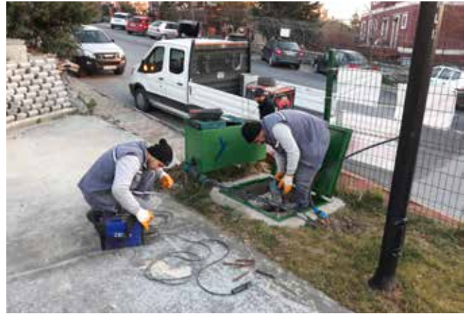
> HOŞDERE PARKI VANA ODASI YAPIM/MONTAJ
