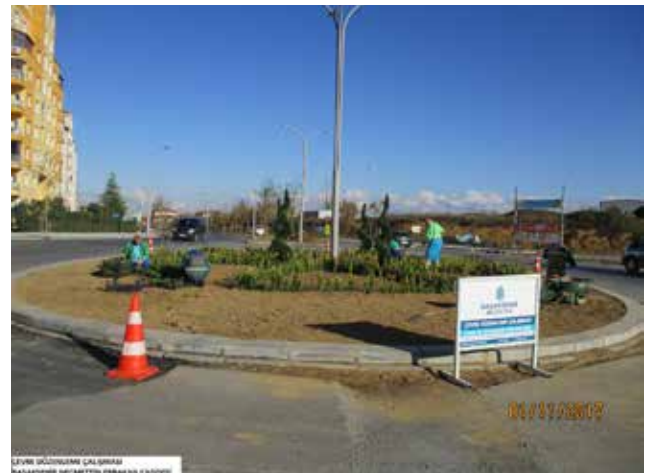
➤ ÇEVRE DÜZENLEME ÇALIŞMASI
