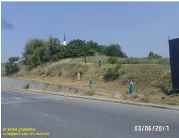
➤ ALTINŞEHİR MAHALLESİ OT BİÇME ÇALIŞMASI
