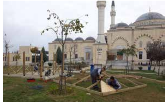
➤ KAMERİYE MONTAJ ÇALIŞMASI
