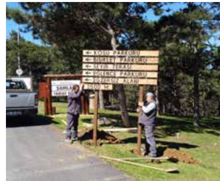
➤ AHŞAP BİLGİLENDİRME LEVHA YAPIM/MONTAJ
