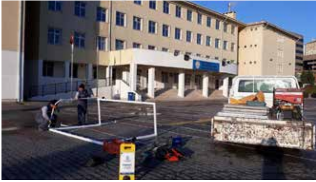
➤ FUTBOL KALE MONTAJ ÇALIŞMASI
