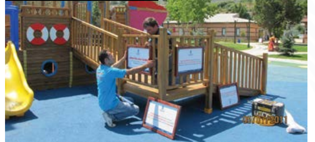
Bahçeşehir Park (Gölet) bakım ve onarım çalışması
