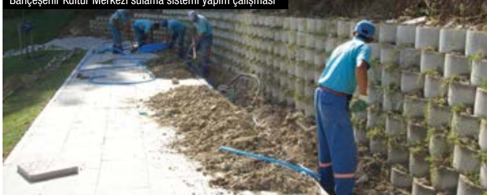
Bahçeşehir Kültür Merkezi sulama sistemi yapım çalışması
