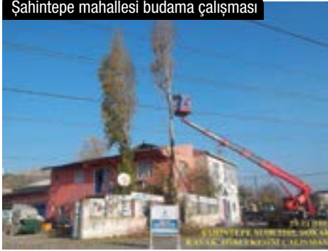
Şahintepe mahallesi budama çalışması
