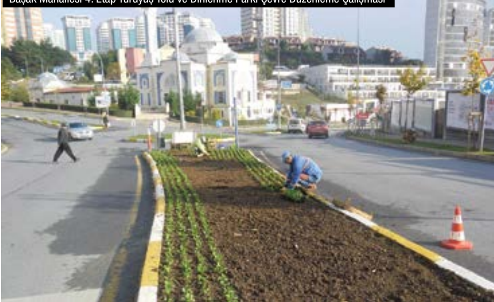
Başak Mahallesi 4. Etap Yürüyüş Yolu ve Dinlenme Parkı Çevre Düzenleme Çalışması
