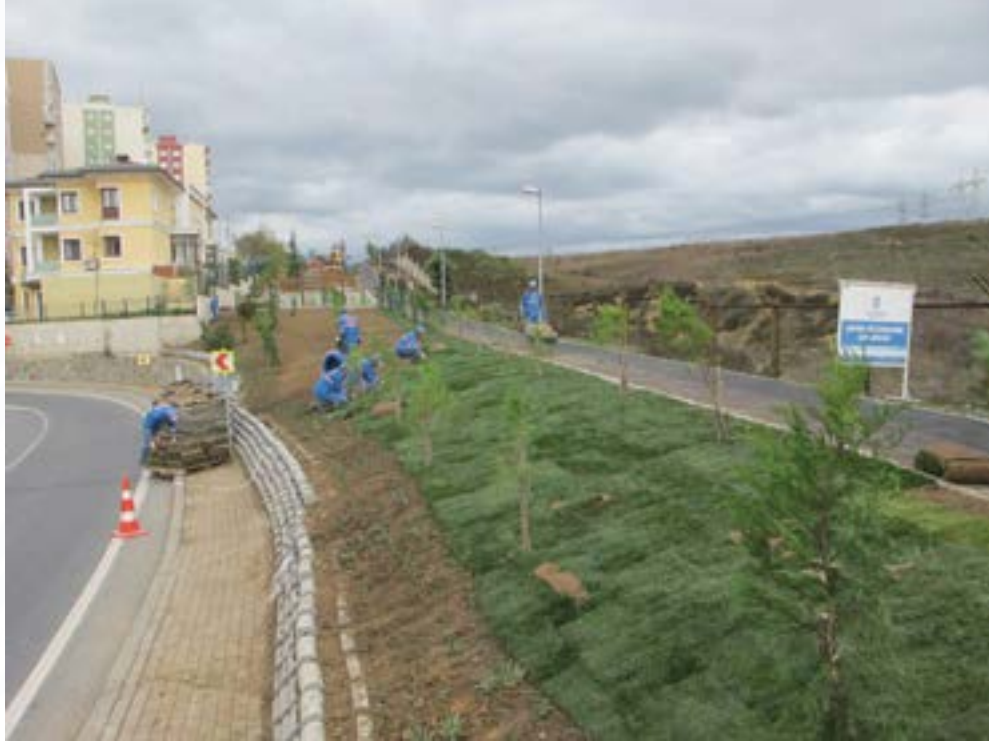
Başak Mahallesi 4. Etap Yürüyüş Yolu ve Dinlenme Parkı Çevre Düzenleme Çalışması
